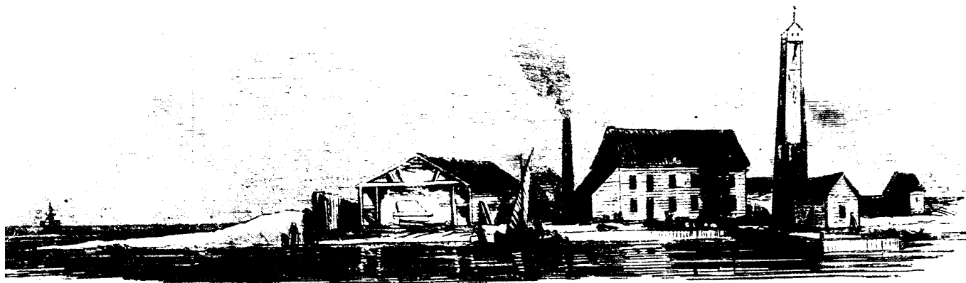
Edificios de la Compañía Accesoría del Tránsito en Punta Arenas (San Juan del Norte)
